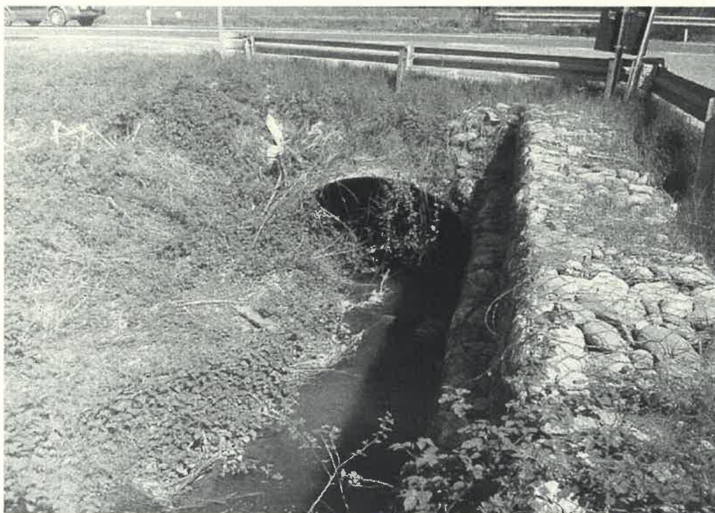
Foto 5.3 - Imbocco a monte della ex. SS. N. 460
