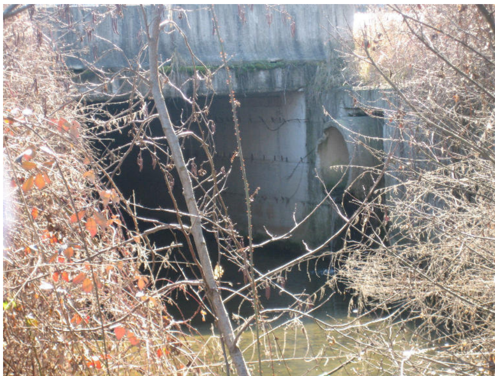
Immagine 1.4 - vista del nuovo attraversamento della S.S. 460
