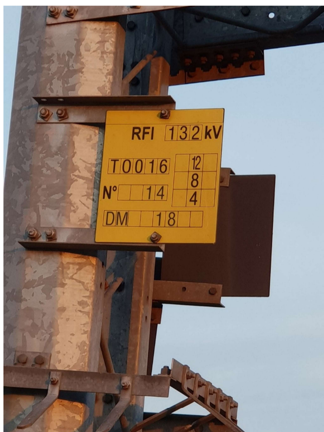
Traliccio doppia terna T.M16-T.T42 – 132 kV
