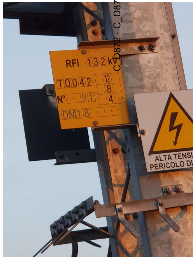
Traliccio doppia terna T.M16-T.T42 – 132 kV
