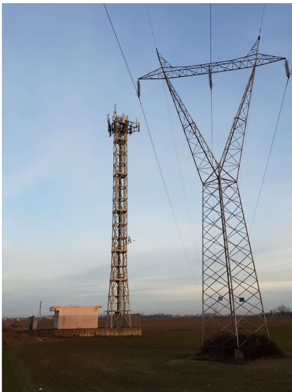
Traliccio linea non identificata
