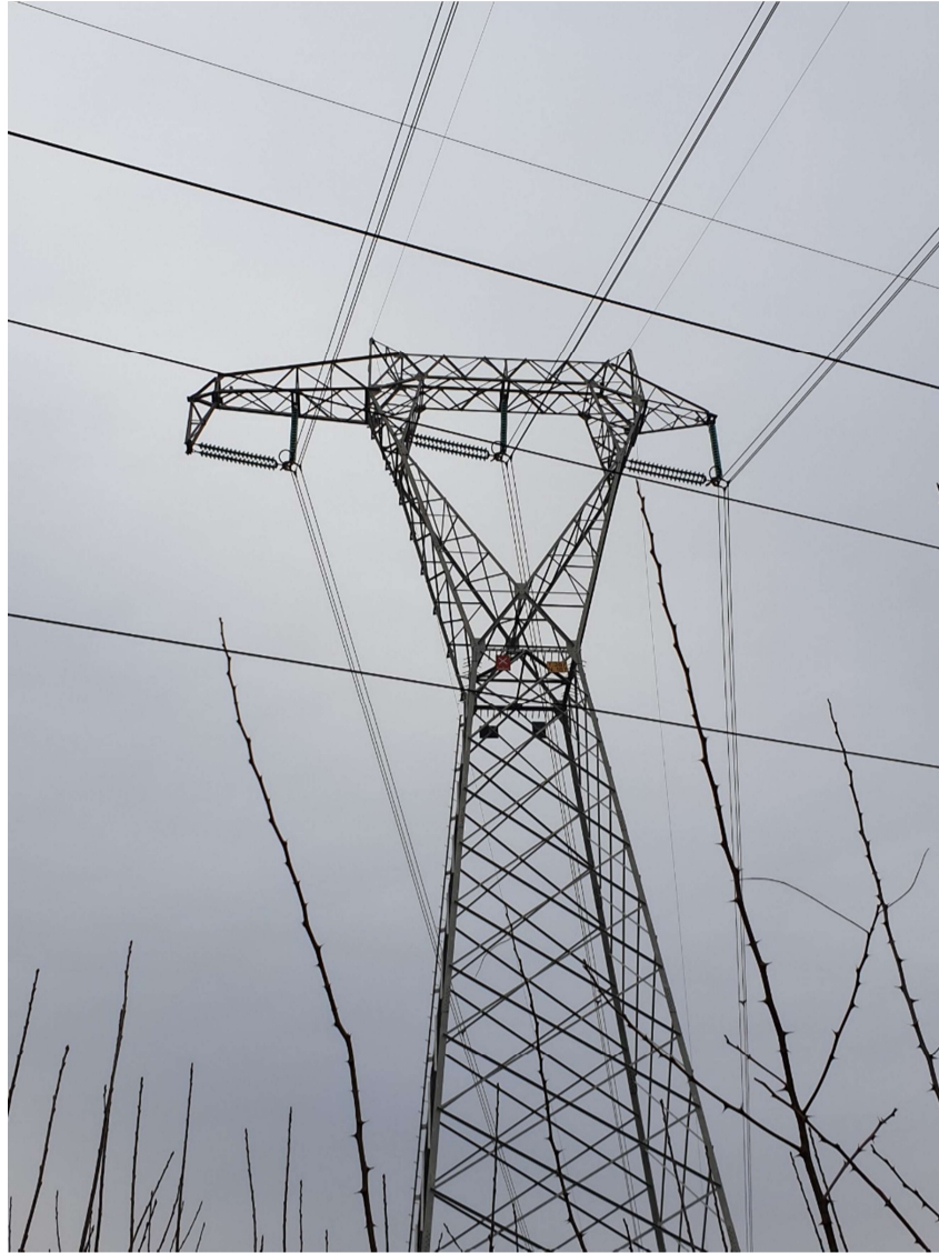
Traliccio linea T.387 – 380 kV
