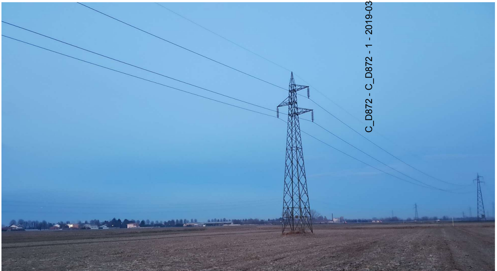
Traliccio linea T.467 – 132 kV
