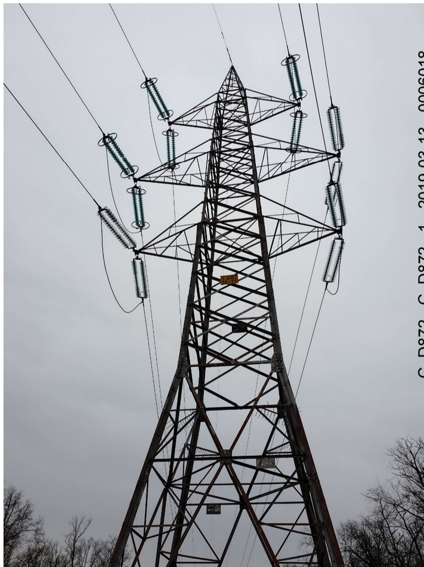
Traliccio linea T.287 – 220 kV
