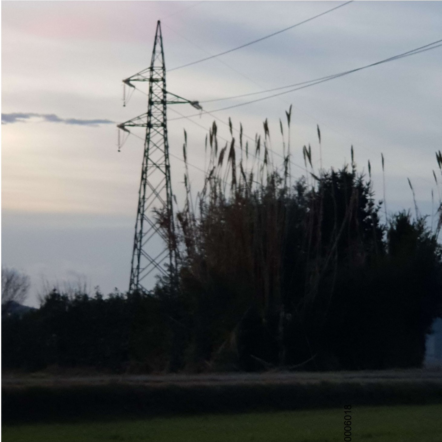
Traliccio linea T.439 – 132 kV
