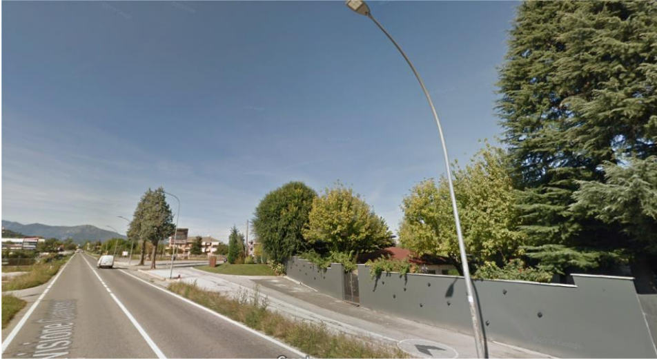
Vista da sud in direzione nord dalla SP422 zona TA01
