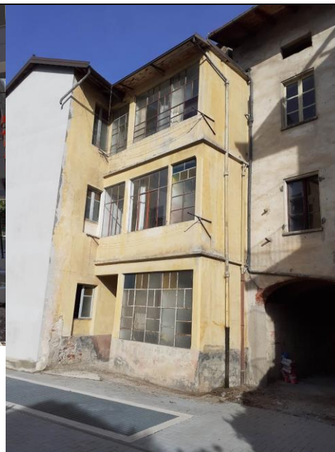
Vista interno cortile
