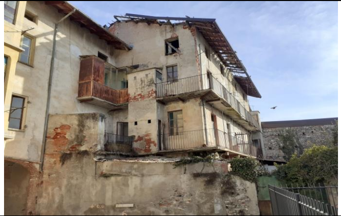
Vista interno cortile
