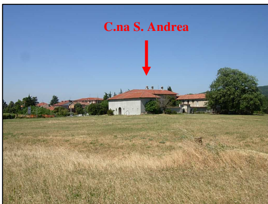
Vista da SSE
