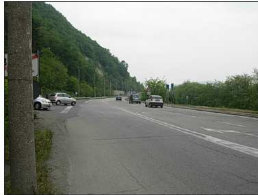
Vista da SSW
