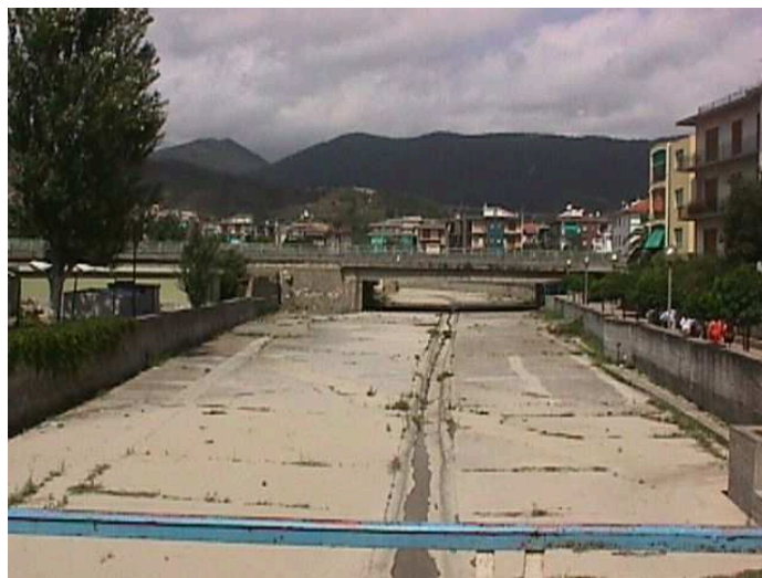
Figura 2.6.1.9: T. Crovetto – tratto plateato a monte della copertura
