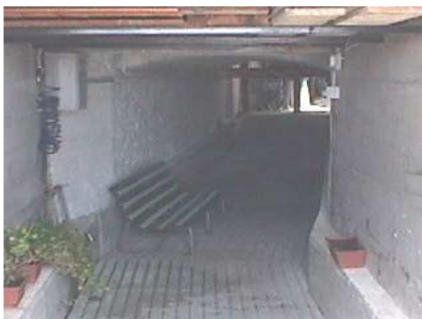
Figura 2.6.2.3 – Rio Nechiazze-Rio Laiolo: sottopassaggio della via Aurelia.
