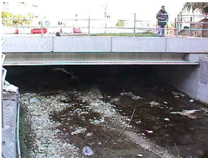
Figura 2.6.1.6: Rio Coreallo – imbocco copertura
