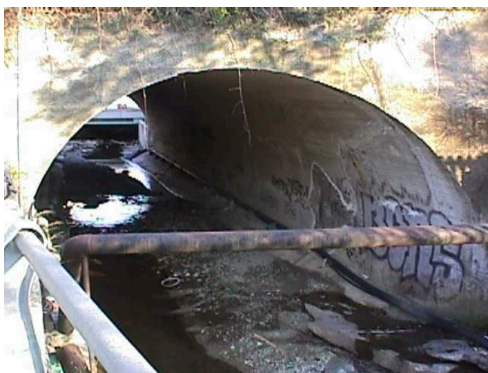
Figura 2.6.1.7 – Rio Coreallo: copertura attraversamento ferroviario
