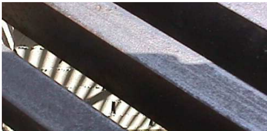
Figura 2.6.2.2 – Rio Nechiazze –Rio Laiolo: particolare dello scatolare in c.a. della copertura.
