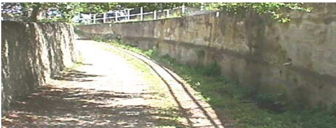
Figura 2.6.2.3.1 – Rio Chiariventi: alveo subito a monte dell'Aurelia. Il muro dell'argine sinistro ha altezza costante di circa 1.6 m, mentre in sponda destra l'argine ha altezza variabile. La strada è larga circa 2.9 m.
