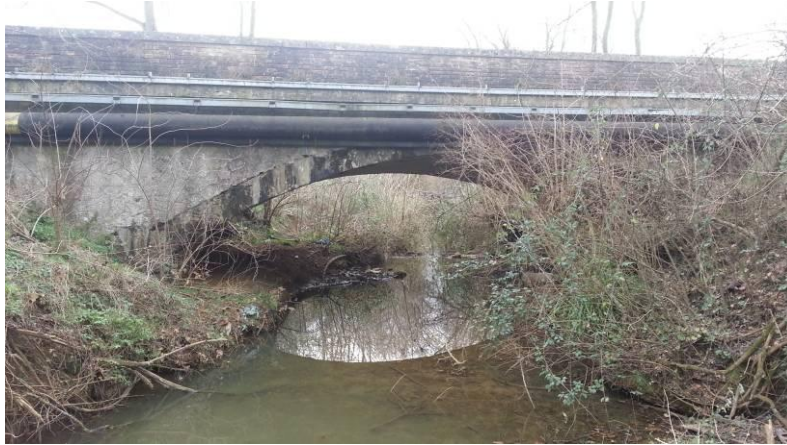
Foto 22 – Torrente Rigo, vista attraversamento della SR n. 73 Senese Aretina
