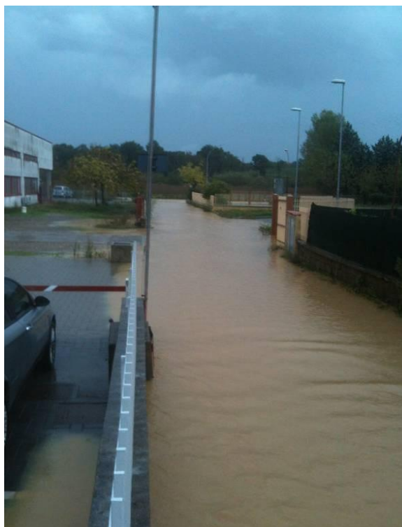
Foto 9 - Vista di Via Adige verso la SR 73 (ottobre 2013)
