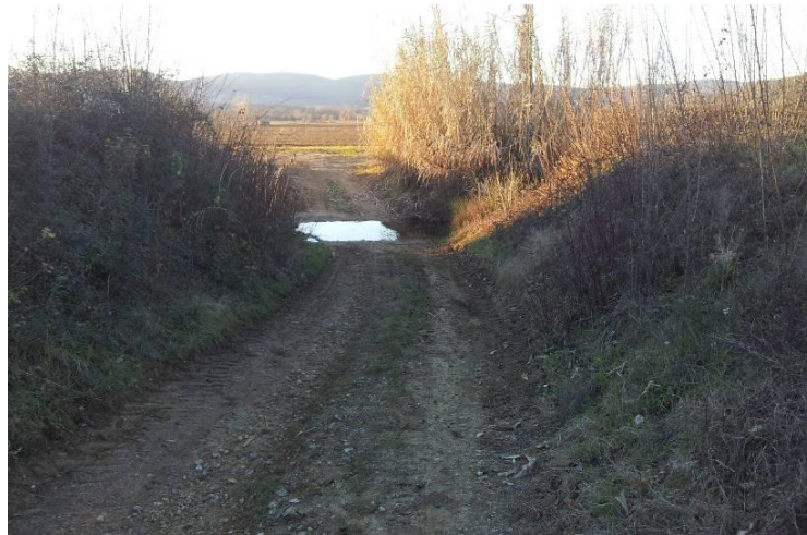
Foto 18 – Guado esistente sul Torrente Rigo (vista da sponda sx)
