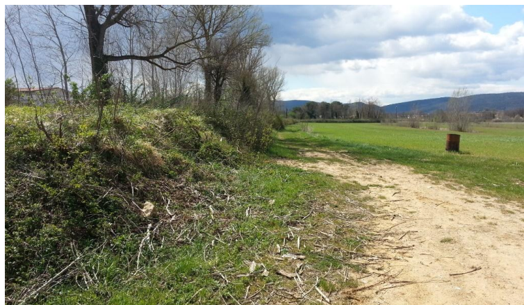
Foto 19 - Vista dell'argine in destra idraulica del Torrente Rigo a valle del guado esistente
