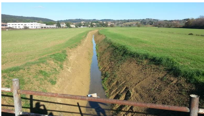
Foto 13 - Fosso Serpenna, vista a monte dell'attraversamento SC di Cerreto
