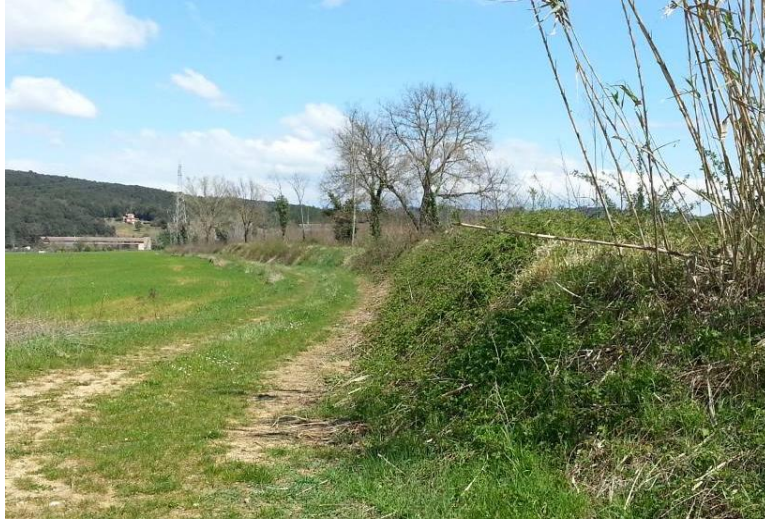
Foto 17 – Vista dell'argine in destra idraulica del Torrente Rigo a monte del guado esistente
