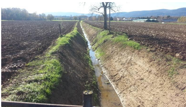
Foto 15 - Fosso Serpenna, vista a valle dell'attraversamento della SC di Cerreto
