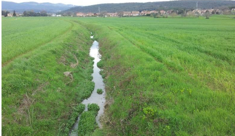
Foto 11 - Fosso Serpenna, vista di valle da attraversamento SC delle Volte Alte
