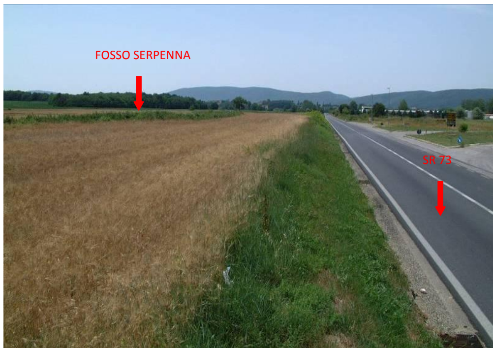
Foto 1- Vista della SR 73 in prossimità dell'insediamento produttivo di Pian dei Mori (incrocio con Via Po)
