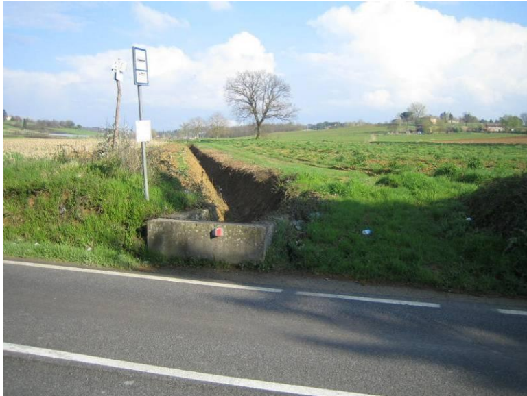
Foto 2 - Vista dell'arrivo della scolina sulla SR 73 in prossimità del Pod. Casa al Piano
