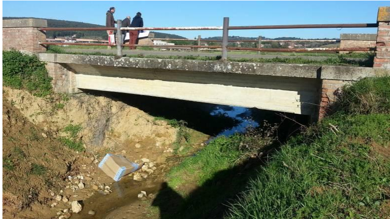
Foto 14 - Fosso Serpenna, attraversamento della SC di Cerreto
