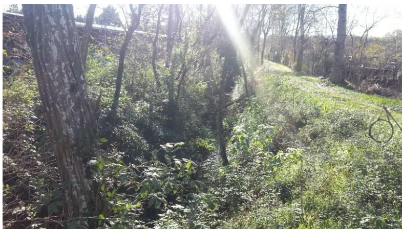
Foto 21 – Torrente Rigo, vista a valle dell'attraversamento su Via Adige (da notare il notevole sviluppo di vegetazione arbustiva ed arborea in particolare in sponda sinistra)
