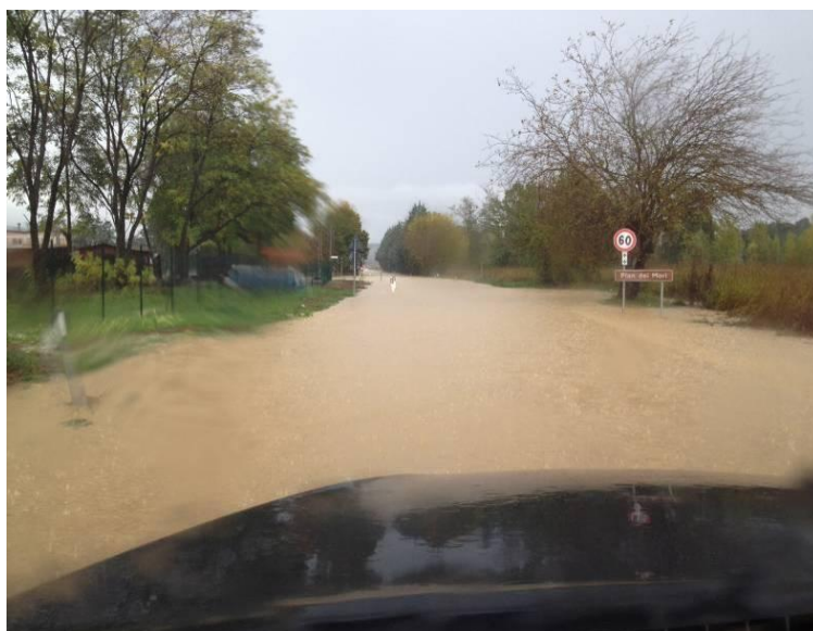
Foto 10 - Vista della SR 73 a monte del ponte di attraversamento sul T. Rigo (ottobre 2013)
